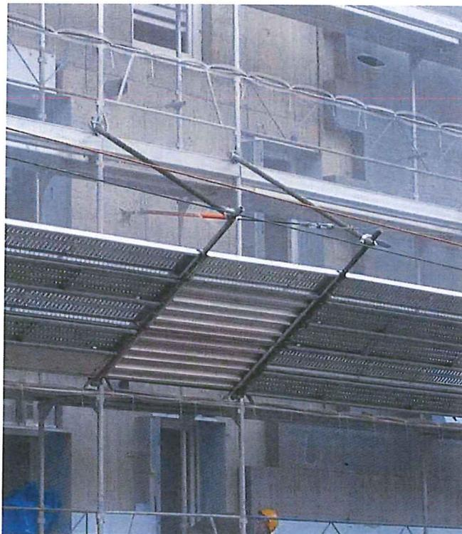
Exemple de protection physique de la ligne de contact
